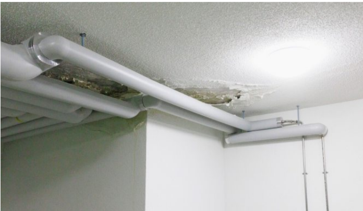
Zu viel Feuchtigkeit: Der Putz bröckelt von der Kellerdecke.
